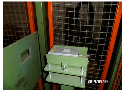
图 2: Dimetix 传感器的安装
