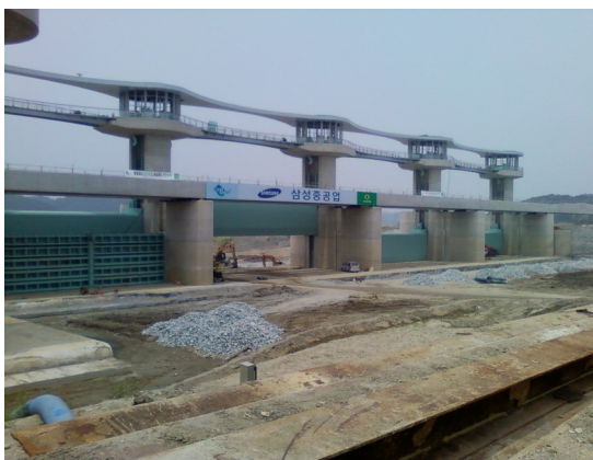
Abb 1: Schleusentore im Bau
