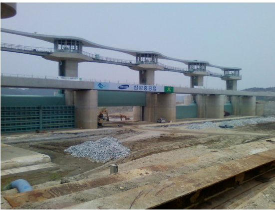
图 1: 正在建造的防洪闸门
