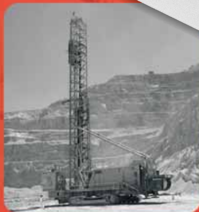
Misure di avanzamento
